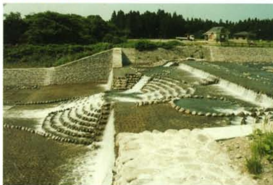
魚類に配慮した床固工 (奈曾川)
