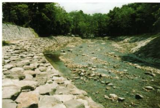
景観に配慮した護岸工 (大川袋沢川)
